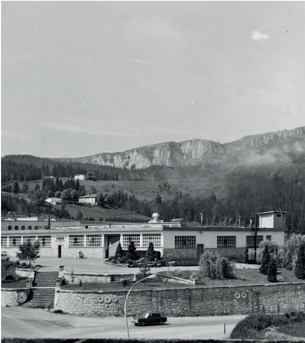
Installations Betik à Azkoain (Oñati) année 1963
